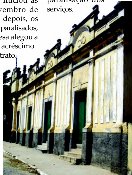
Prédio onde deve funcionar o museu está abandonado
