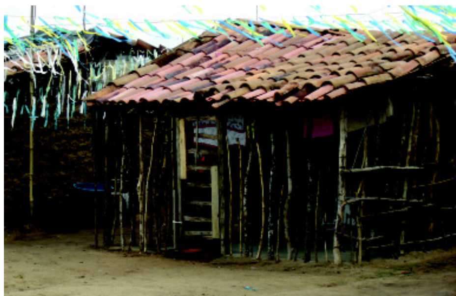
Cem famílias do Assentamento Nossa Senhora da Penha, que há dois anos vivem em casas de taipa, serão beneficiadas com casas de alvenaria no bairro Areial, em Mamanguape
