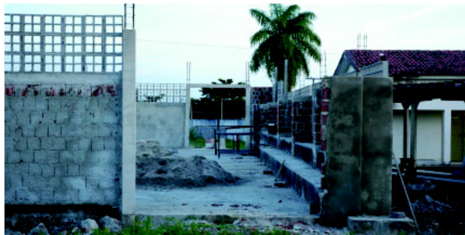
Atendendo à recomendação do MPPB, a Secretaria Estadual de Educação já iniciou as obras na quadra da escola Osvaldo Pessoa. A quadra estava desativada, em fevereiro deste ano
