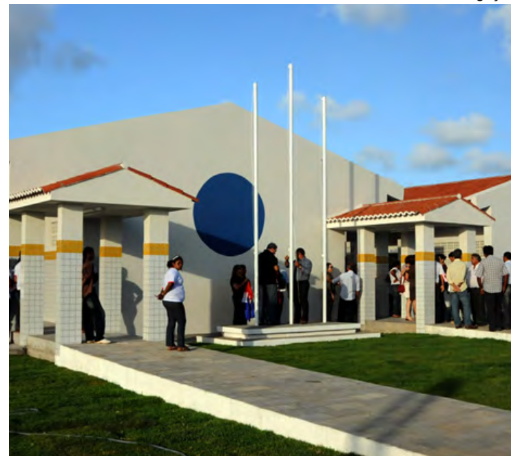
CABEDEL - Escola pública é inspecionada pelo MPPB
