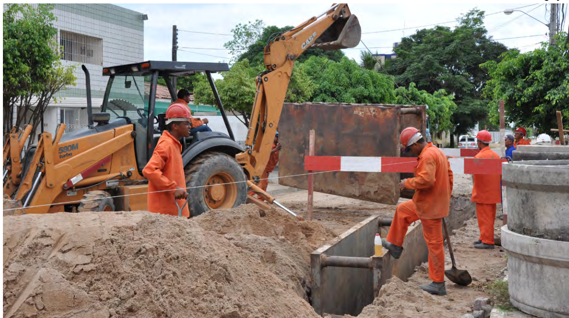
COMUNIDADE MUTIRÃO - Obras para o abastecimento de água devem começar em 30 dias
