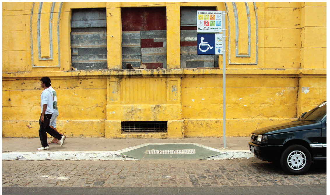
EM SOUSA - Rampa feita em calçada não atende às normas técnicas e dificulta a locomoção de cadeirantes
