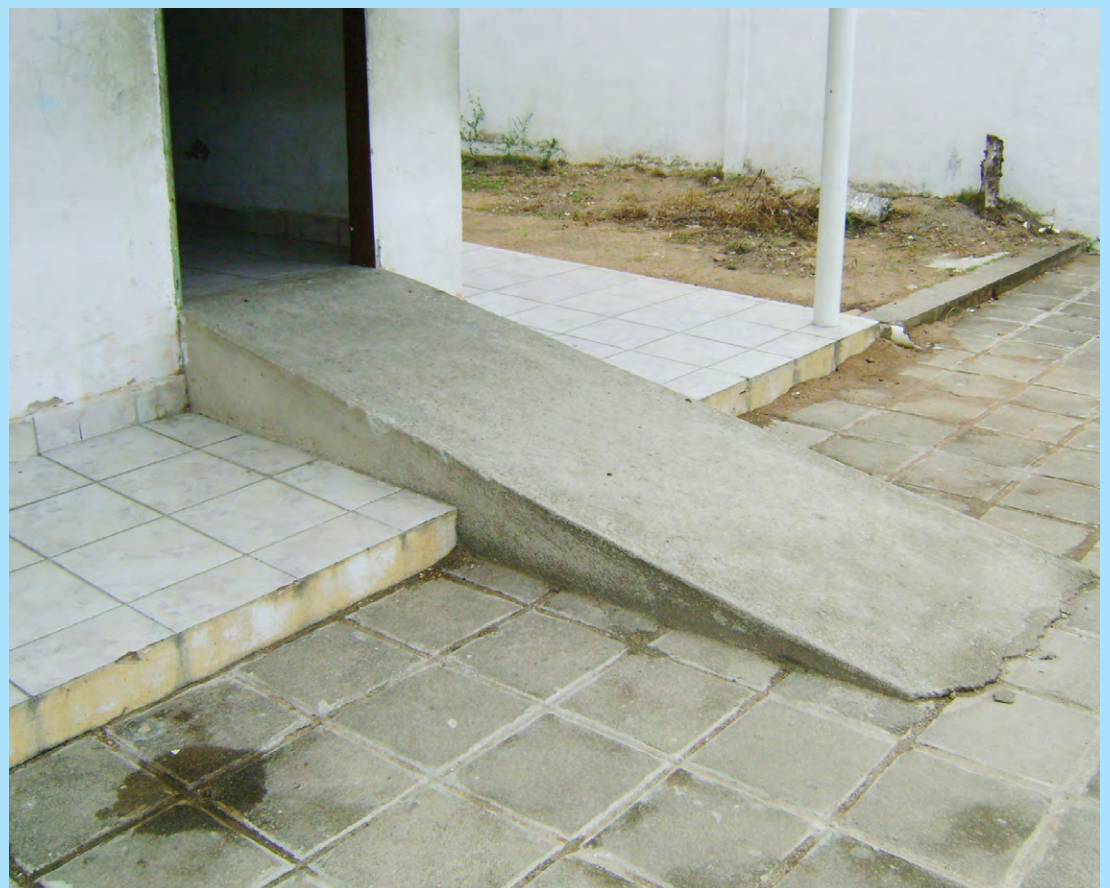
SEM ACESSIBILIDADE - Escolas têm rampas com inclinações que colocam em risco cadeirantes
