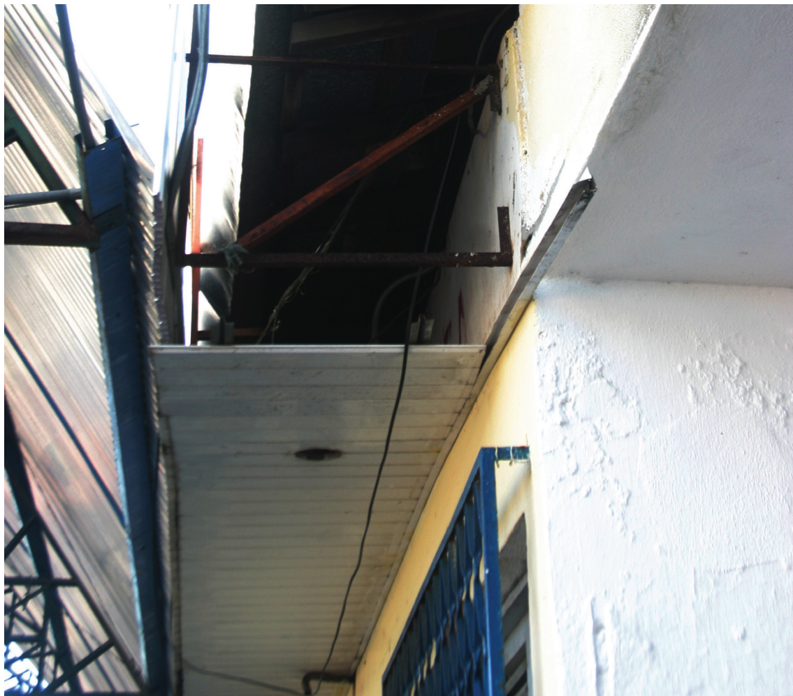
REFORMA - Apesar das recomendações do MP, obras em escolas estaduais ainda não foram feitas
