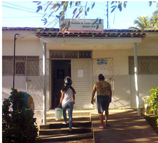
ROGER- Estrutura estava em condições precárias
