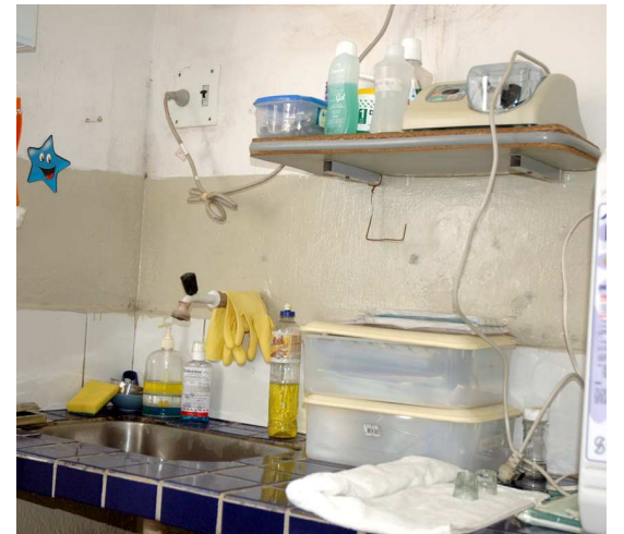
INADEQUADO- Espaço é dividido com vários setores
