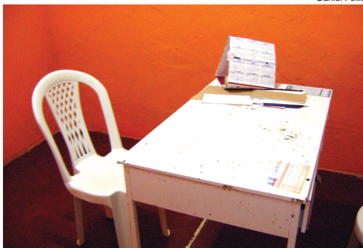
FERRUGEM - O mobiliário da unidade de saúde apresenta oxidação
