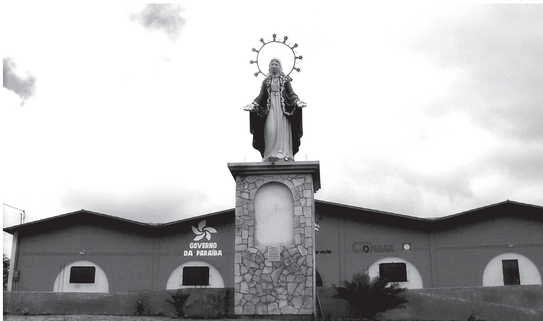
INTERDIÇÃO- O abrigo Bom Pastor teve dois dormitórios interditados por falta de condições
