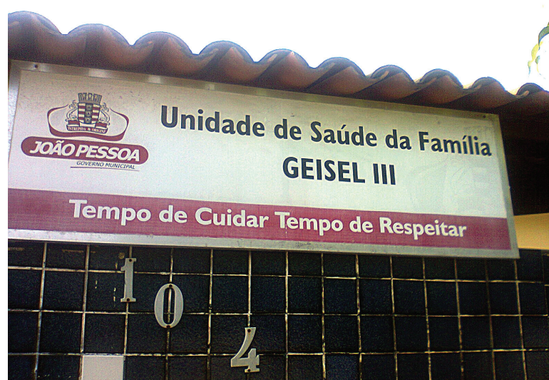
INSPEÇÃO - Unidade apresentou problemas de acessibilidade
