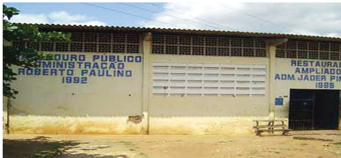
RECUPERAÇÃO - Prefeitura solicitou suspensão do processo para a realização das obras no local
