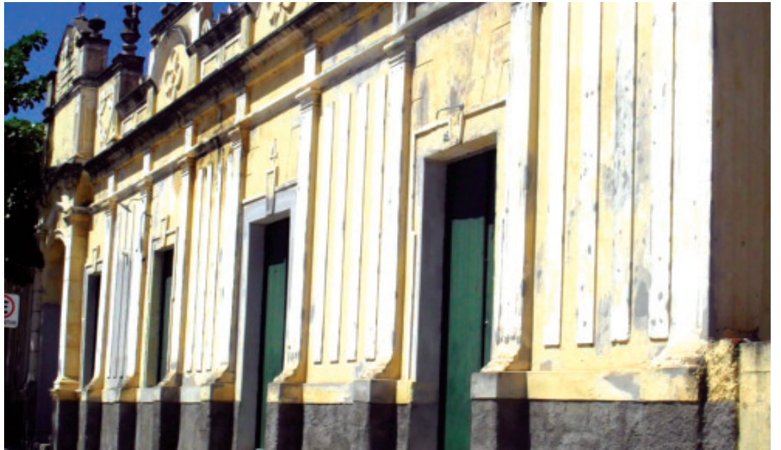
EM PRINCESA ISABEL - Promotoria cobrou a retomada das obras no prédio onde vai funcionar o museu
